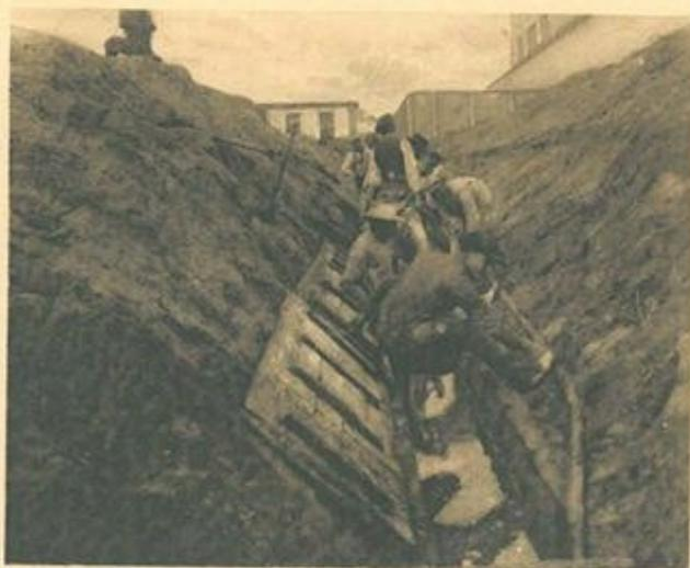
Cavo sotterraneo in conduttura di cemento, ricoperta da tavoloni.
